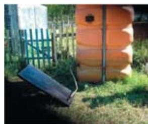
ность, поднимается вверх в бак-накопитель и отдаёт тепло находящейся в нём воде. Холодная жидкость из бака опускается в нижнюю часть солнечного коллектора и нагревается на солнце.
