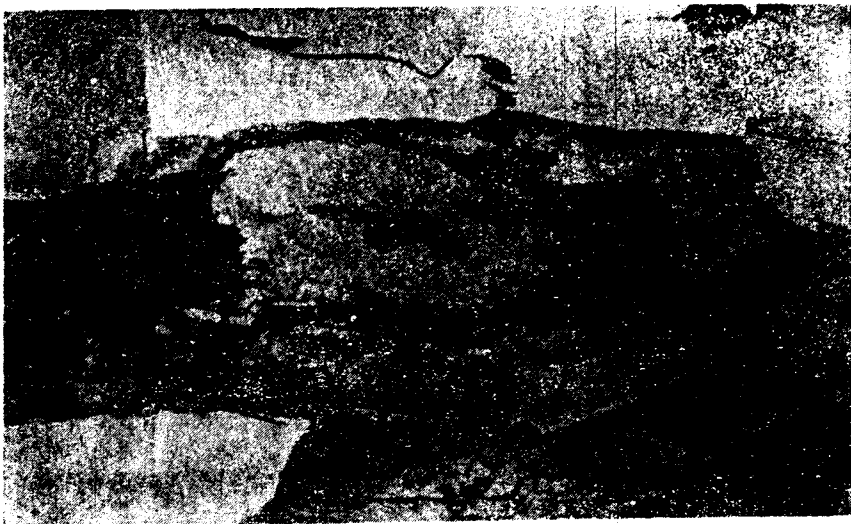
Рис. 1.23. Повреждение простенков в монолитном здании (г. Кишинев, 1986 г.)
