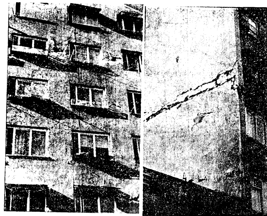
Рис. 1.22. Повреждения 4-й степени в здании, возведенном в скользящей опалубке
