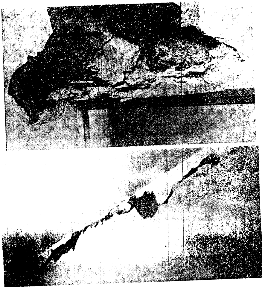
Рис. 1.18. Повреждение перемычек (а) и сопряжений (б) монолитных стен со сборными перекрытиями (г. Кишинев, 1986 г.)
